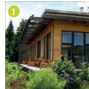
L'emploi de matériaux écoresponsables et l'intégration d'une fenestration importante sont des mesures encouragées (Ecohabitation)
