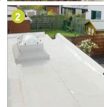
Toiture blanche (Derbigum)
