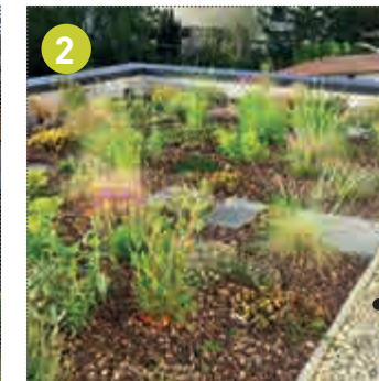
Toit vert extensif (Toiture.ecovegetal)
