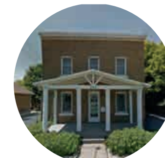
MAISON À TOIT PLAT
