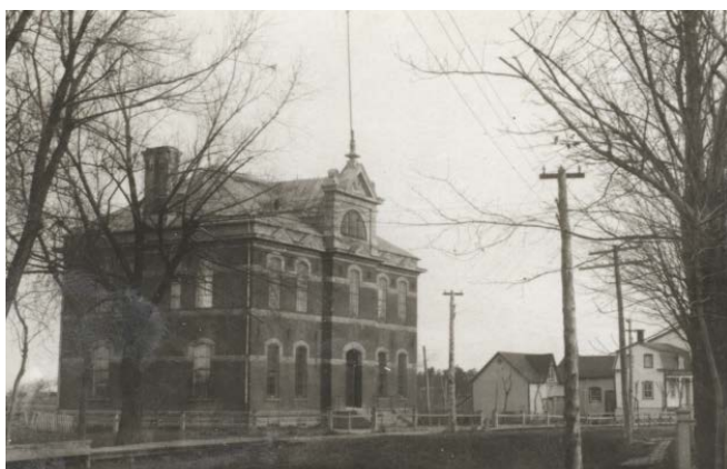
Édifice du Comté 1921 - Crédit photo : Bibliothèque et Archives nationales du Québec
