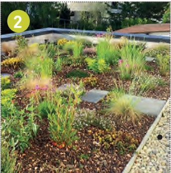
Toit vert extensif (Toiture.ecovegetal)
