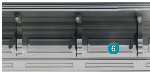
Corniche à consoles de l'ancien magasin général Viau. 118-120, rue Principale, Saint-Louis-de-Gonzague.
