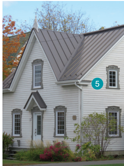
Le retour de corniche, fréquent sur les édifices néogothiques, comme c'est le cas sur cet édifice. 175, rue Saint-Joseph, Sainte-Martine.
