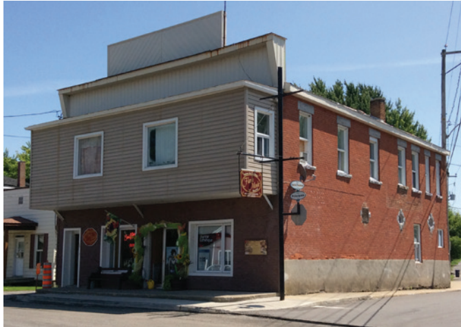
Exemple de maison Boomtown. 129, rue Principale, Saint-Louis-de-Gonzague. Photo: UQAM.
