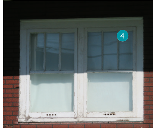
Fenêtre à guillotine à petits-bois. 261, rue Principale, Saint-Urbain-Premier.
