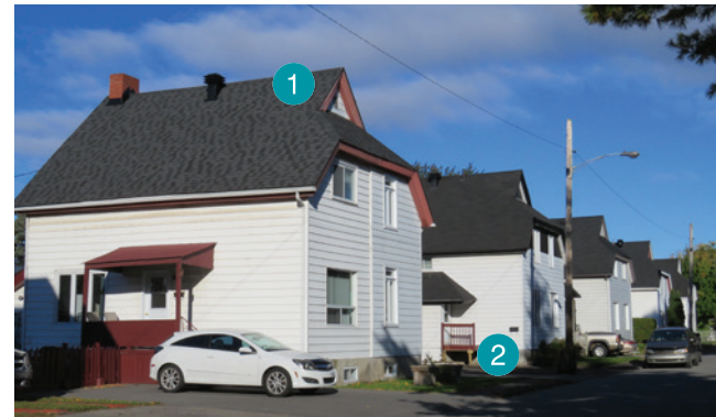
Maisons jumelées à toit à deux versants avec demi-croupe en façade avant, dotées d'entrées latérales. Rue Whitaker, Salaberry-de-Valleyfield.
