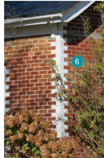
On a rehaussé les chaînes d'angle, les appuis, les jambages et les plates-bandes des ouvertures à l'aide de peinture blanche, à la manière des « jeux de briques » courants dans la région. 423, chemin de la Rivière-des-Fèves Nord, Saint-Urbain-Premier.
