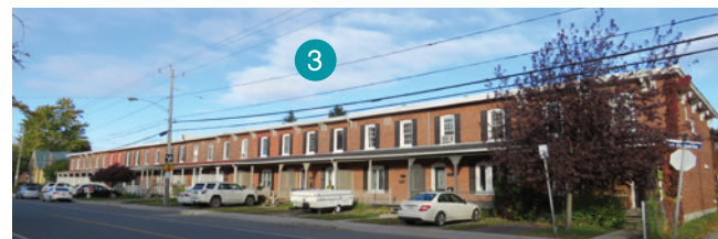
Maisons en rangée à ouvertures décalées. 477-503, boulevard du Havre, Salaberry-de-Valleyfield.
