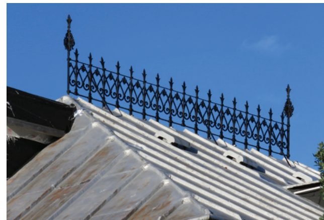
Crête faitière au sommet du toit de l'ancienne maison des contremaîtres. 9, 19 e Avenue, Beauharnois.
