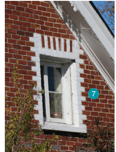
On a rehaussé les chaînes d'angle, les appuis, les jambages et les plates-bandes des ouvertures à l'aide de peinture blanche, à la manière des « jeux de briques » courants dans la région. 423, chemin de la Rivière-des-Fèves Nord, Saint-Urbain-Premier.
