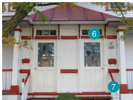
Impostes, colonnes et consoles au portail de la maison jumelée à toit à deux versants avec lucarnes. 466-468, boulevard du Havre, Salaberry-de-Valleyfield.
