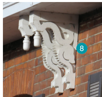
Consoles doubles découpées. Maisons en rangée à ouvertures décalées. 477-503, boulevard du Havre, Salaberry-de-Valleyfield.
