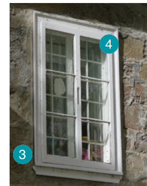
Fenêtre à battants à 24 petits carreaux. La contrefenêtre est à grands carreaux. 76, rue François-Branchaud, Beauharnois.
