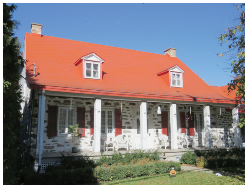
Maison érigée en 1823 pour Pierre Rousselle, d'où l'appellation éponyme attribuée au seul immeuble patrimonial classé dans la MRC de Beauharnois-Salaberry. 160, rue Saint-Joseph, Sainte-Martine.
