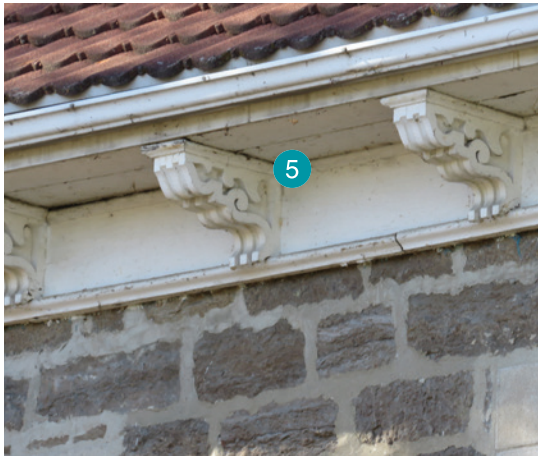
5 Consoles de la corniche. 246, rue Saint-Joseph, à Sainte-Martine.
