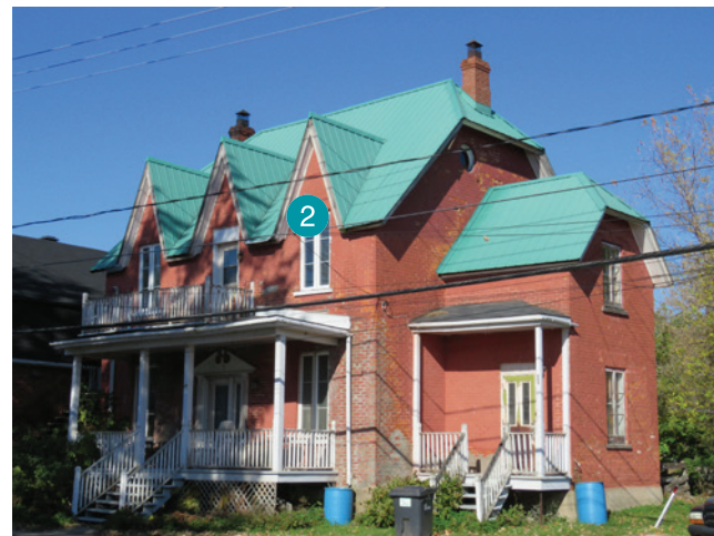
Exemple de maison de style Arts and Crafts. 112-114, rue Principale, Saint-Louis-de-Gonzague.
