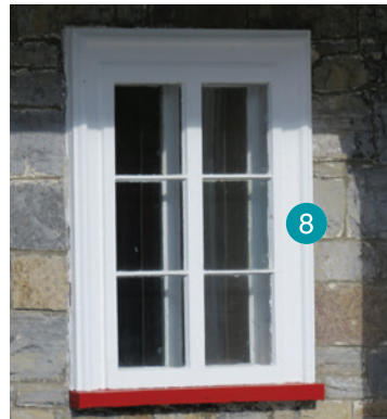
Fenêtre à battants à grands carreaux et contrefenêtre. 168, rue Saint-Laurent, Beauharnois.
