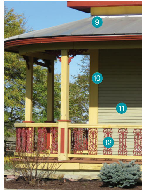
Garde-corps constitué d'éléments décoratifs en fonte moulée. Planche cornière et revêtement de planche à clin. 772, rang du Dix, Saint-Étienne-de-Beauharnois.
